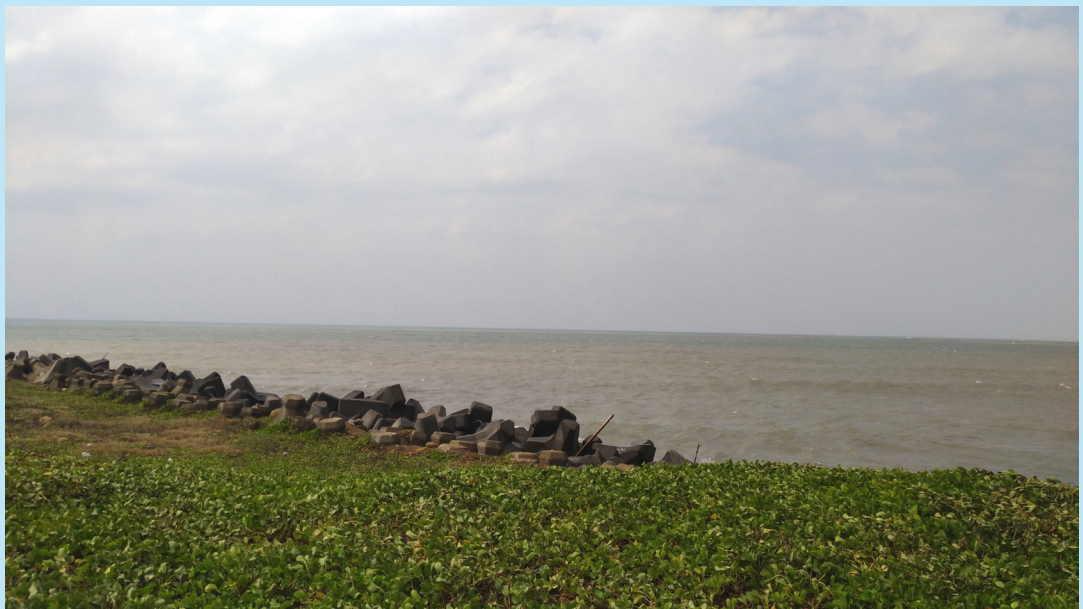
曾文溪出海口堤防（曾翊菁 2017.10.22 攝）
